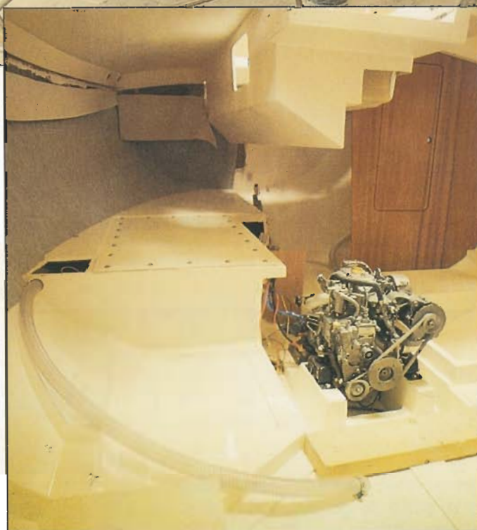
Als een afgemonteerd dek op een romp wordt geplaatst zijn de motor en hoofdschotten al aangebracht. De rest van de betimmering wordt via de kajuitingang naar binnen gebracht.
